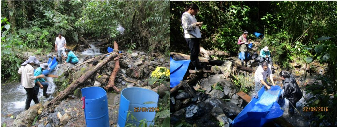
Foto 7. Medición de caudal en el afluente 1 de La Astillera (a la altura de la vía)
