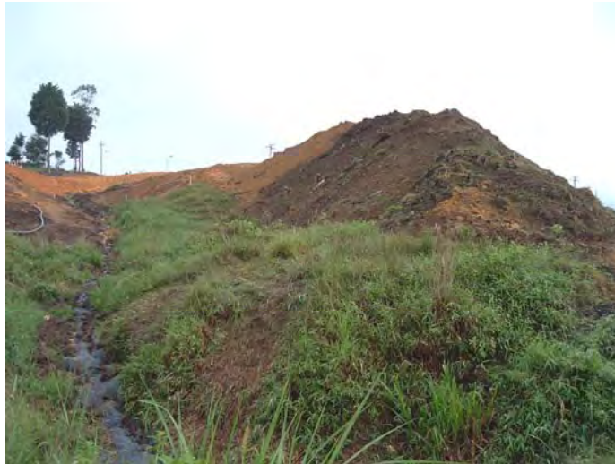
Foto 161 Intervención de cauces y contaminación con sedimentos por el arrastre de materiales en actividades de construcción de urbanizaciones, que no sólo no separan ni almacenan los suelos orgánicos, si no que, además, no toman medidas contra el arrastre de suelos.
