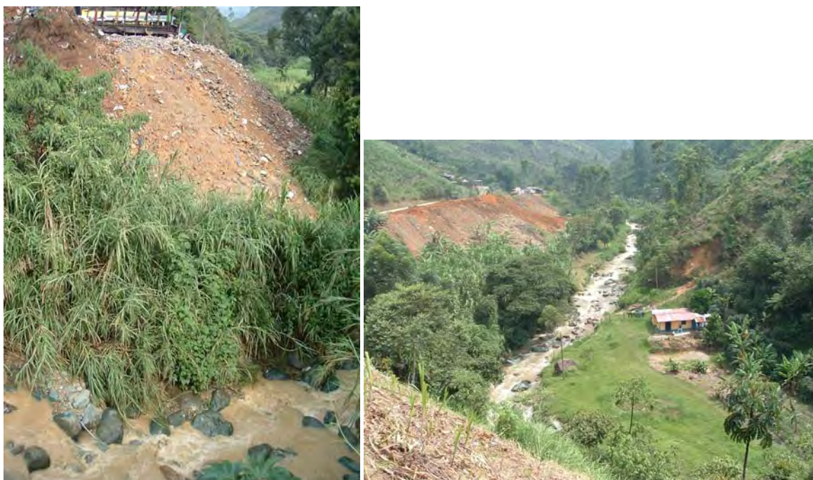
Fotos 164 y 165 Escombreras improvisadas en retiros de La Limona y La Doña María, que finalmente aportan sólidos a las corrientes, contaminando y poniendo en riesgo viviendas aguas abajo
