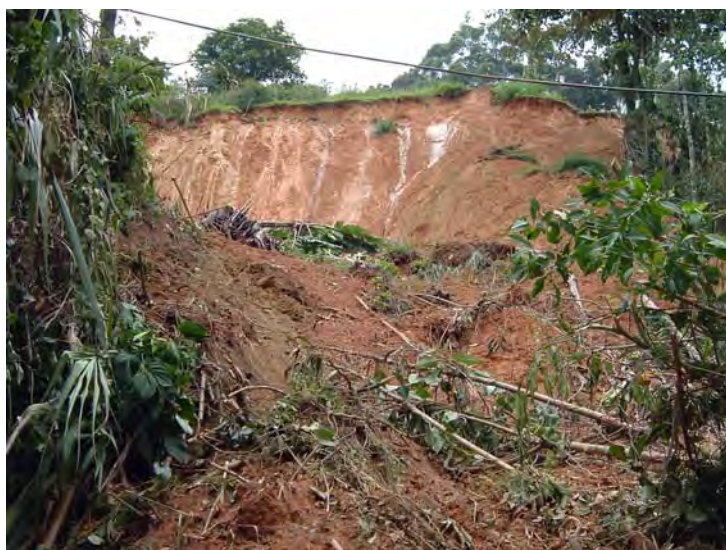
Foto 5 Derrumbe en la parte alta de la Q. Barro Azul
