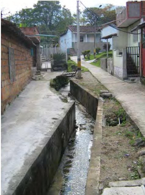
Foto 49 Aguas residuales, en La Pradera
