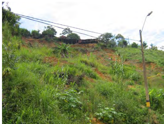
Foto 21 Deslizamientos en Montañita
