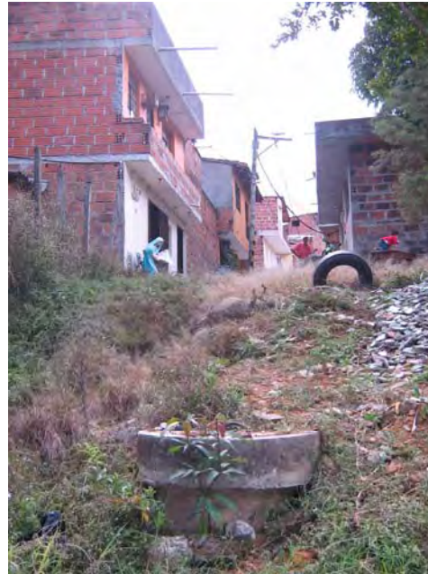
Foto 50 Alcantarillado en La Pradera
