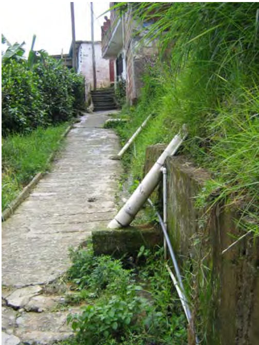
Foto 19 Alcantarillado en maría auxiliadora
