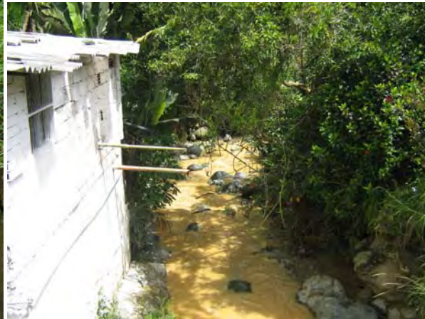
Foto 20 Aguas residuales sobre la manguala
